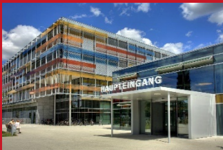
Photo: Universitätsklinikum Heidelberg
